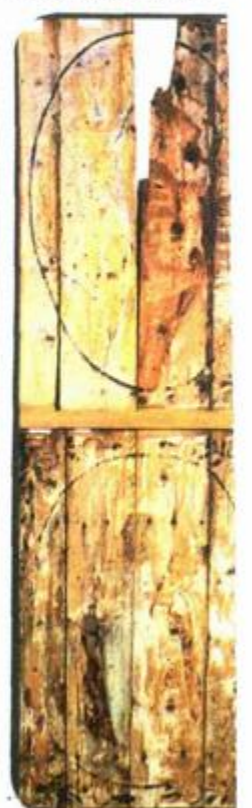
Konzervatorsko-restauratorski radovi na oslikanom drvenom stropu u crkvi sv. Petra i Pavla u Trvižu
